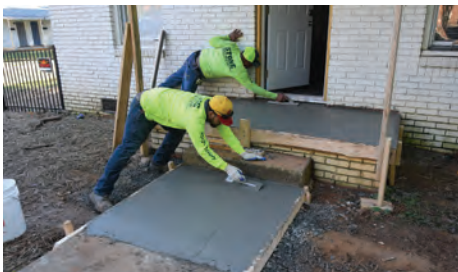
Finishing a pour on day 2
