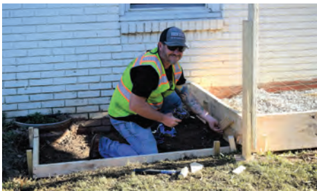
Form work before the pour
