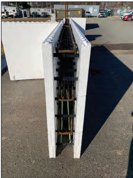
Fig. 1: ICF mockup wall prior to concrete pour
