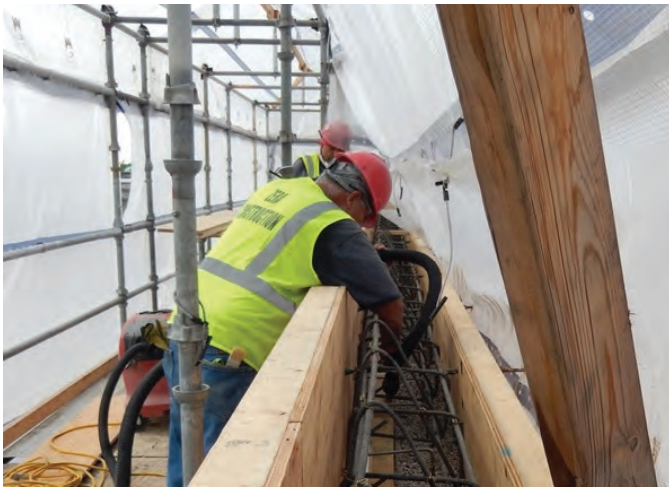
Fig. 5: Form and pour application
