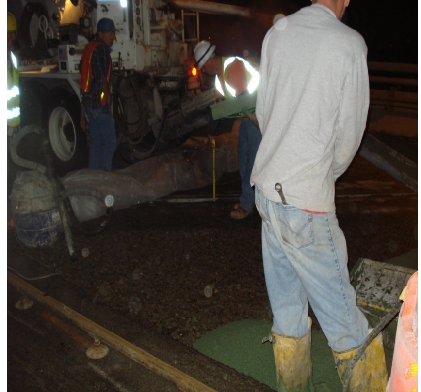
Pouring the Latex
