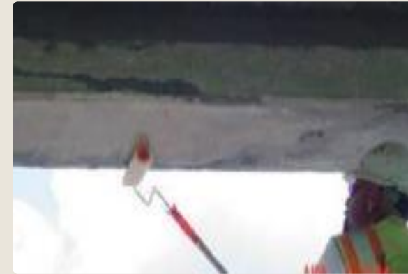
Application of Primer
