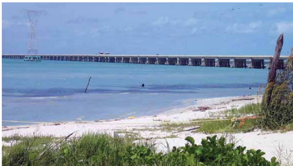
La Unidad Bridge
