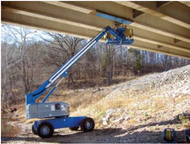
Application of primer
