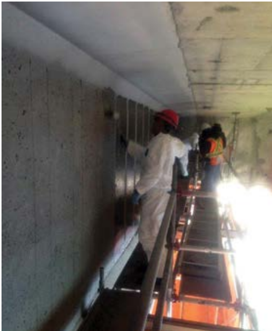
Fig. 2: Application of primer
