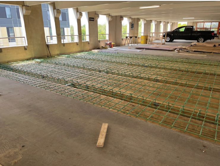
Image 10: Reinforcement for monolithic pour
